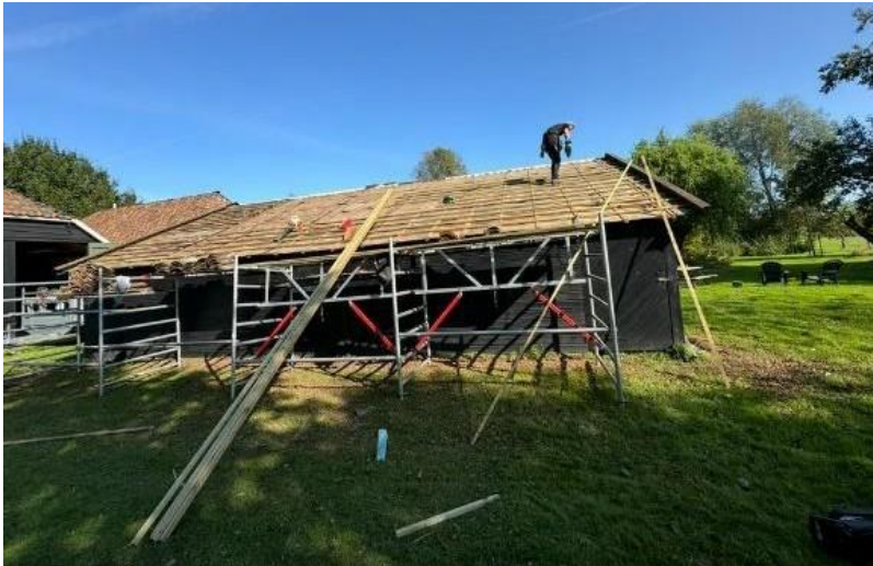
Retirar las tejas. Todo el tejado se dota de una nueva estructura de madera.
