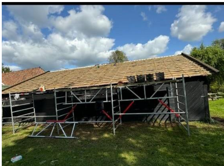
Listo el tendido de las nuevas tejas.
