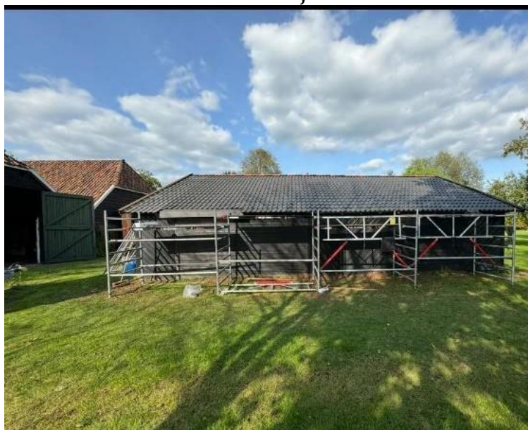
Instalación de nuevas tejas.
